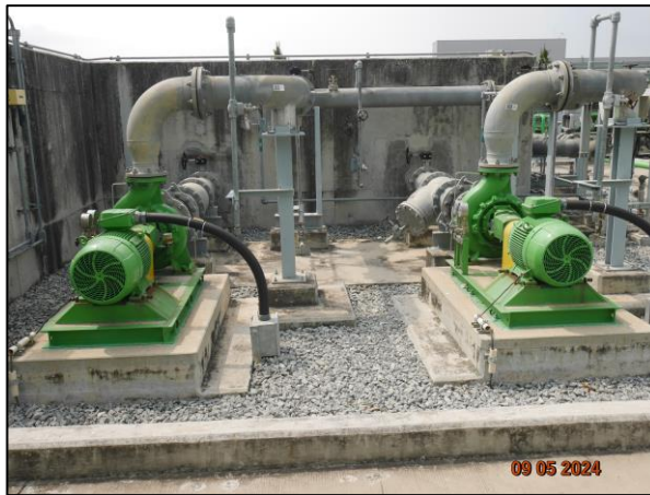
รูปที่ 2.8 ฐานคอนกรีตลดแรงสั่นสะเทือน
