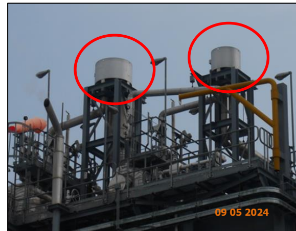
รูปที่ 2.9 อุปกรณ์ลดเสียง Silencer
